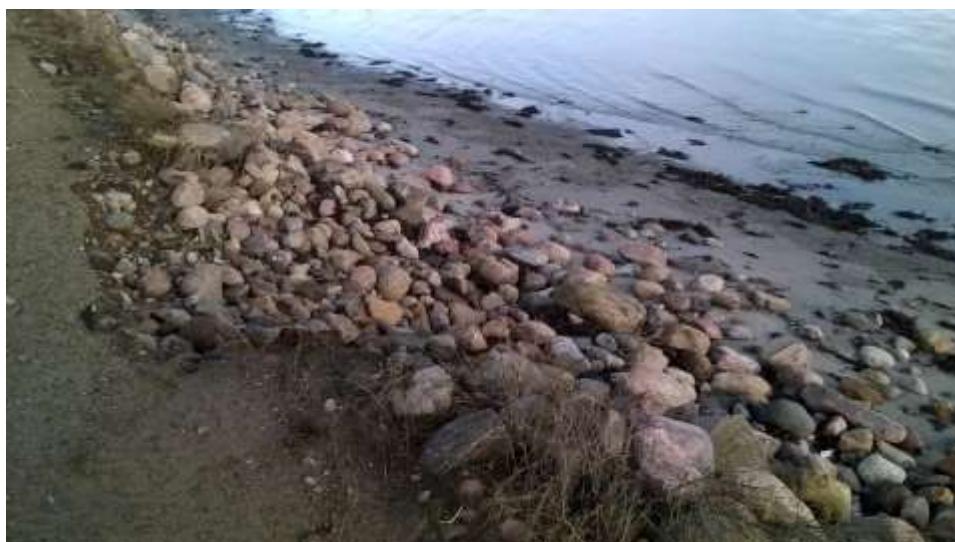
Figur 3-11 Skader på skråningsbeskyttelsen efter stormhændelse den d. 22. november, 2015. Stenene er trukket ud af skråningsbeskyttelsen, og der er erosionskår i stien (Foto: Dorte Wissendorff).
