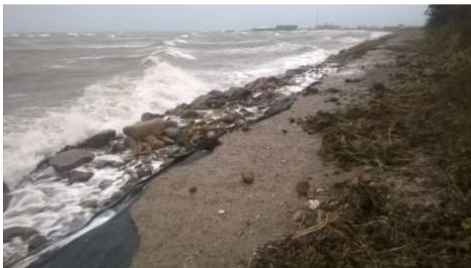
Figur 3-10 Stormhændelse ved skråningsbeskyttelse d. 22. november 2015. (Foto: Dorte Wissendorff).
