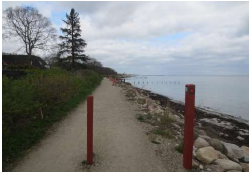
Figur 3-13 Sti beskyttet af skråningsbeskyttelsen. Billede taget 21-04-2016 (Foto: NIRAS).
