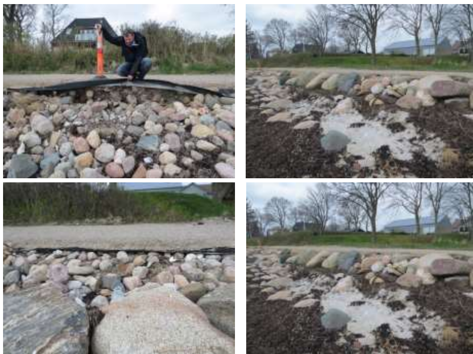
Figur 3-17 Billederne af den beskadigede skråningsbeskyttelse. Størrelsen på dækstenene varierer fra 15 cm til 50 cm. De store sten ligger oftest tilbage, mens de mindre små sten er suget ud af bølgerne. Stenenes middeldiameter vurderes at have været væsentligt under 30 cm. Billeder taget 21-04-2016 (Foto: NIRAS).
