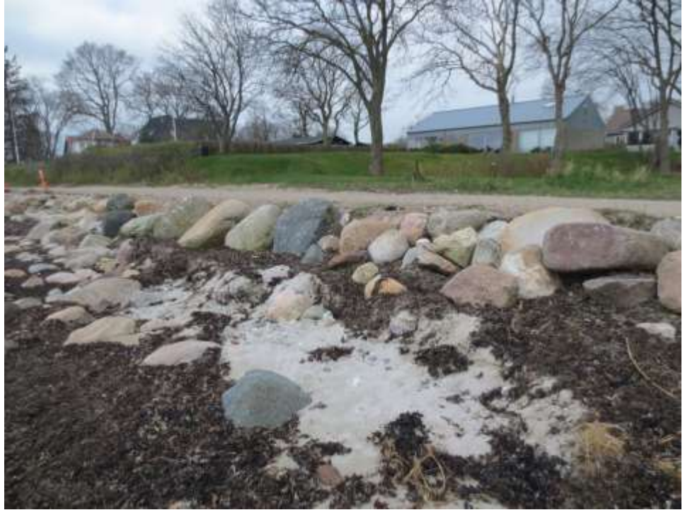
Figur 1-1 Skader på skråningsbeskyttelsen, der beskytter en kyststi. Billede taget 21-04-2016 (foto: NIRAS).
