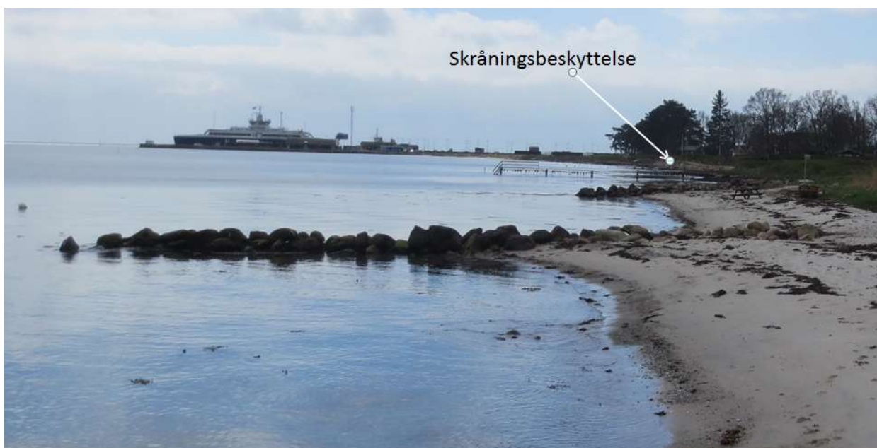
Figur 3-12 Høfdeholdernes sydligste høfder inden skråningsbeskyttelsen, som ses i baggrunden. Billede er taget 21-04-2016 (Foto: NIRAS).
